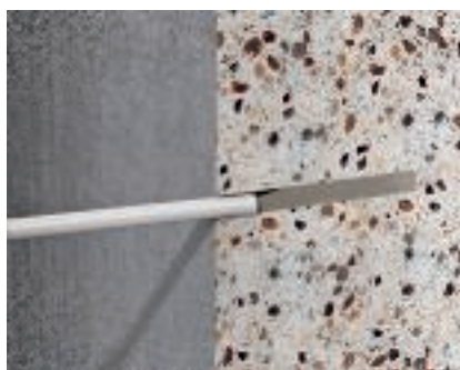
Ввод инъекционной шпатлевки Выдавить инъекционную шпатлевку в отверстие.
