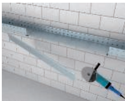
Т-образное ответвление с помощью угловой секции Извлечение боковой стенки из кабельного лотка для больших расстояний.
