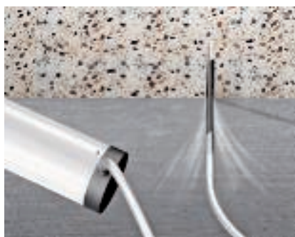
Продувка отверстия Удалить пыль из отверстия.
