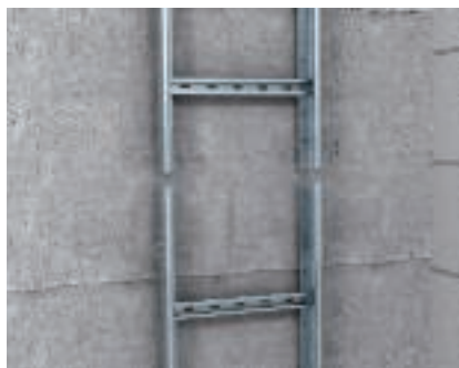
Продольное соединение вертикальных кабельных лотков лестничного типа Соединение вертикальных кабельных лотков лестничного типа LG и SSL 60 с помощью соединителей LVG.
